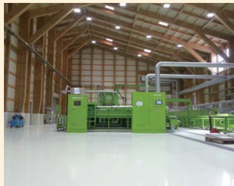
工場内部に、幅約18m、奥行約34mの大空間を実現
